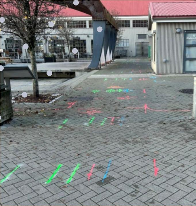
IDENTIFICAMOS, LOCALIZAMOS Y PROPONEMOS LOS MEJORES MÉTODOS NO INVASIVOS PARA DESCARTAR ENCONTRAR O UBICAR SERVICIOS ENTERRADOS COMO CIMENTACIONES, TUBERÍAS, VARILLAS, ENTRE OTRAS.
